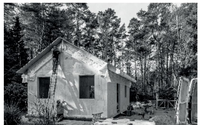
▲ Dieses Tinyhaus mit einer Wohnfläche von 36 qm wurde mithilfe des Steko-Bausystems errichtet. Foto: Biber GmbH
